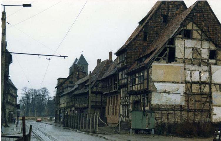
Abbildung 1: Verfallenes Fachwerkhause in Halberstadt 1985 (Foto: Hajotthu)
